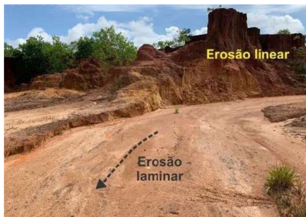
Figura 02 – Diferença entre erosão laminar e linear Fonte: FUSHIMA et al. (2020)
